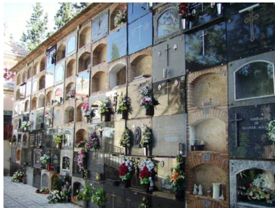
Nueva construcción de nichos (1936).
